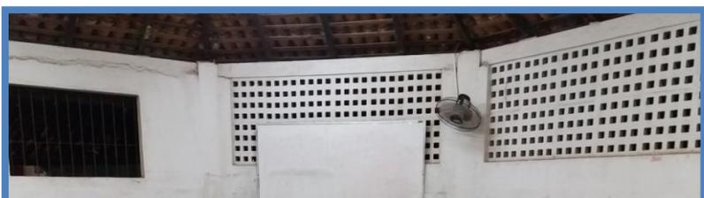
FIGURA - Furos de Ventilação na Sala de Aula
